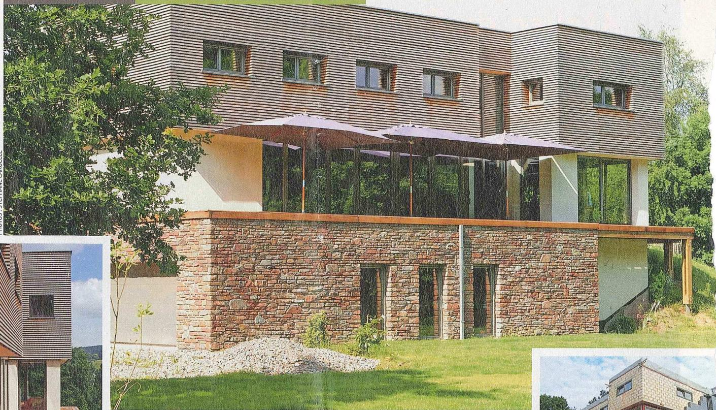
Le revêtement extérieur varie en fonction du volume. La zone des caves est ainsi recouverte de moellons tandis que le rez-de-chaussée est orné de crépi, et que les chambres sont revêtues d'un bardage en bois posé par-dessus le crépi. La pose ajourée du bardage en cèdre, à l'étage, permet que le grisaillement du bois se voie moins grâce à l'espace laissé libre entre chaque planche. Les photos à droite témoignent qu'il fait bon vivre dans cette maison passive.
